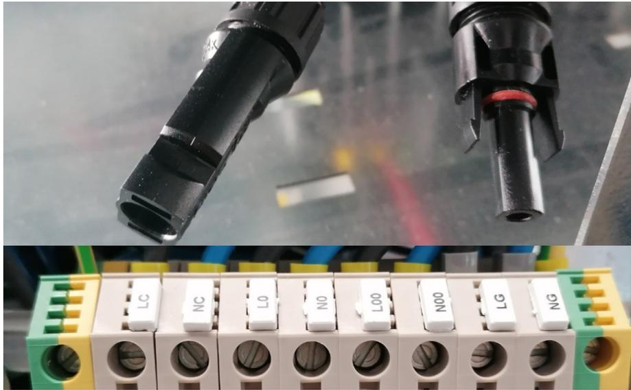
Al ser un sistema todo en uno, no hay ensamblajes de componentes externos. Para la instalación es suficiente llevar los ramales fotovoltaicos desde el panel de campo directamente a los conectores MC4 provistos en el sistema, conectar el contador de distribución a la entrada de la red, conectar el contador de producción a los terminales y finalmente cablear la salida en caso de que se prevea el uso del Backup (modo de respaldo).
