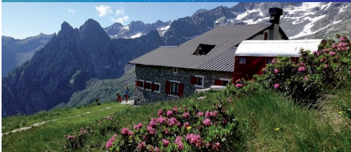
RIFUGIO OMIO Impianto 2 kWp | Capacità 20kWh
